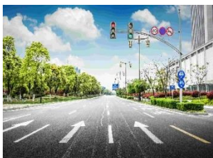
Благоустройство и ремонт дорог 152,6 млн.рублей
